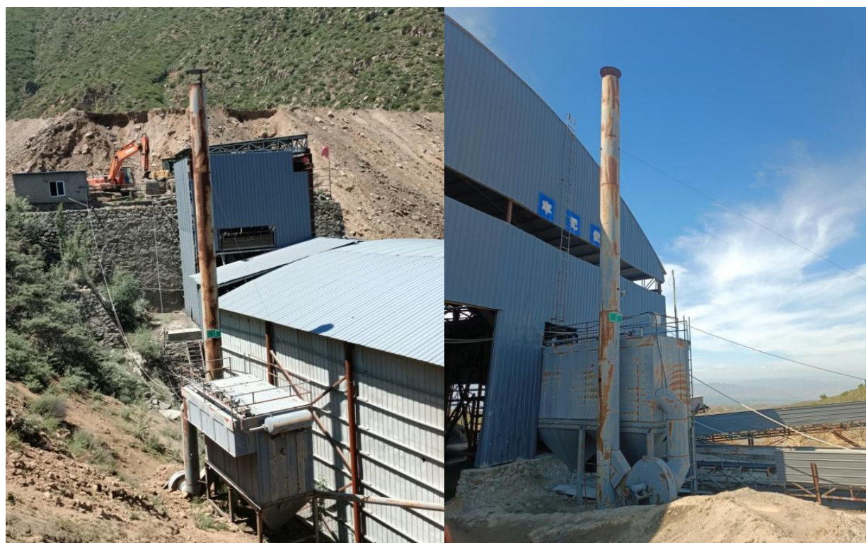
图 4-1 1 车间和 2 车间排气筒
